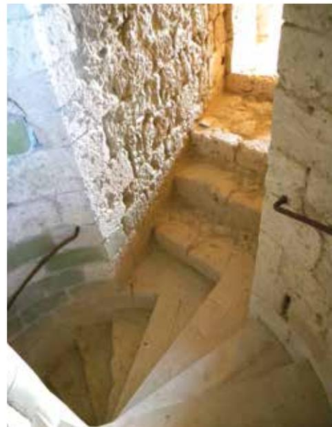
de rénover les quelques marches en pierre très endommagées entre le rez-de-chaussée et le premier étage. Une table d'orientation sera installée sur la terrasse et la salle de garde du premier étage sera entièrement restaurée.
