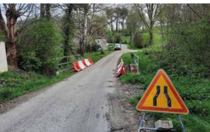
Pont de la Bausse
