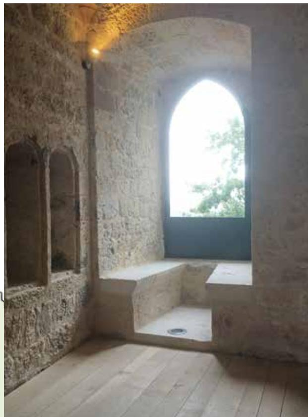
la terrasse, de sécuriser la terrasse avec une lisse et d'installer des tables d'orientation. Une reprise des empochements et un calage des poutres. Une réfection complète de l'unité. Au premier étage, les coussièges ont été rétablis. Plusieurs travaux ont été faits à l'intérieur. Un plancher en chêne massif a été posé, le nettoyage de toutes les pierres, de l'escalier reliant le rez-de-chaussée au premier étage, ont fait l'objet d'une révision.
