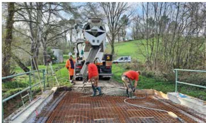
Ferrailage et béton du pont de la Bausse
