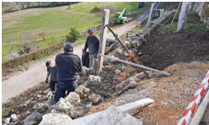
Construction du mur de soutènement
