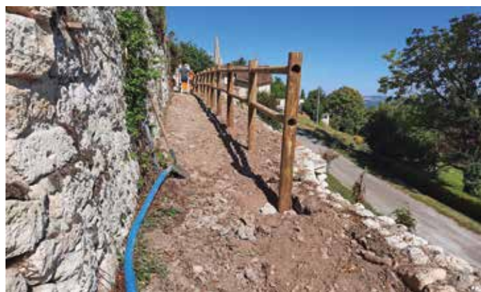
Pose de lisses en bois
