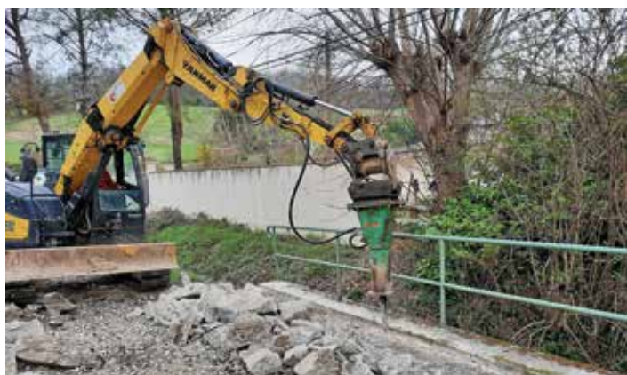
Pont de la Bausse
