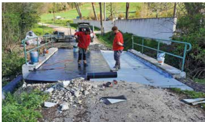
Etanchéité du pont de la Bausse
